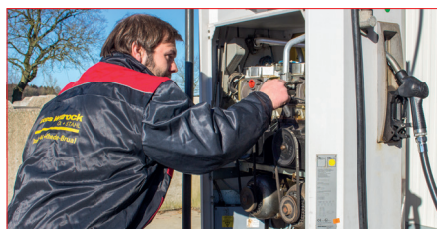
Reparatur und Wartung
